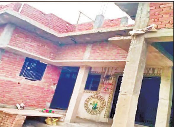
रमवापुर में आईएसआई एजेंट राम सिंह का निर्माणाधीन मकान।
