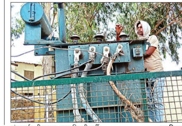
ट्रांसफार्मर की मरम्मत करता बिजली कर्मी।
