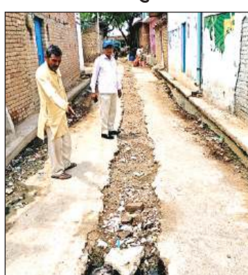
पाइप लाइन डालने के चलते खोदी गई सड़क।
