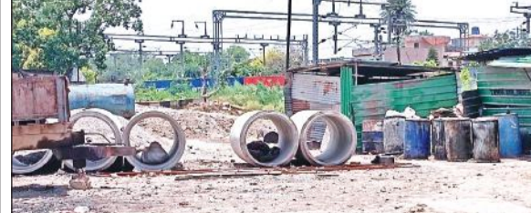
रोडवेज परिसर पर पड़ी आरओबी निर्माण की सामग्री।
