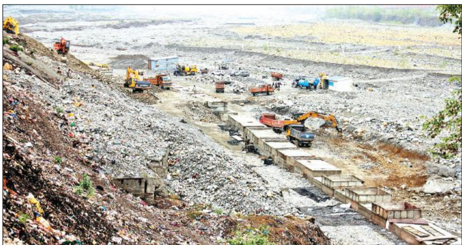
हल्लानी रेलवे स्टेशन के निकट गौला नदी में चल रहा रिटेनिंग वॉल निर्माण। • अमृत विचार
