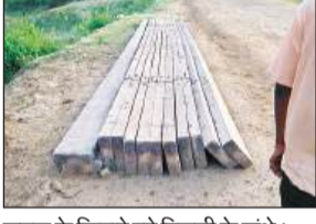
सड़क के किनारे पड़े बिजली के खंभे।
