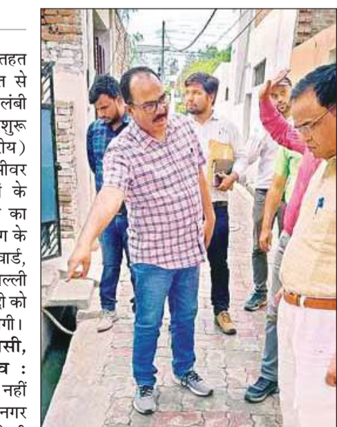
आलमबाग के कृष्णापल्ली में घरों के सीवर लाइन से जोड़े गए कनेक्शन देखते जल निगम के अभियंता।
