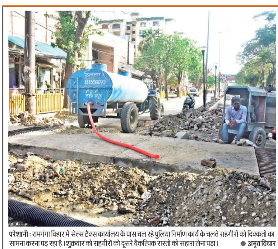
परेशानी : रामगंगा विहार में सेल्स टैक्स कार्यालय के पास चल रहे पुलिसिया निर्माण कार्य के चलते राहगीरों को दिक्कतों का सामना करना पड़ रहा है। शुक्रवार को राहगीरों को दूसरे वैकल्पिक रास्तों को सहारा लेना पड़ा।
