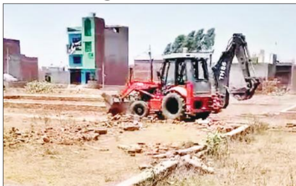
अवैध निर्माण को तोड़ती जेसीबी।
