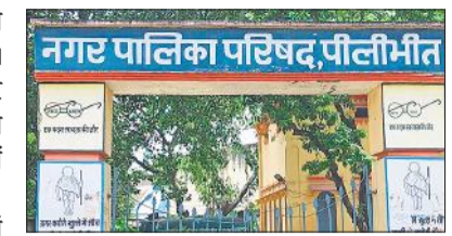
नगर पालिका भवन।
