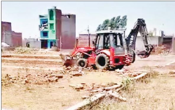
अवैध निर्माण को तोड़ती जेसीबी।
