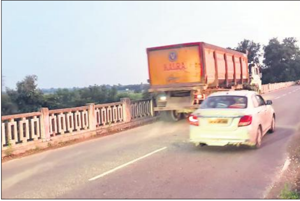
जर्जर सोत नदी पुल से गुजरते वाहन
