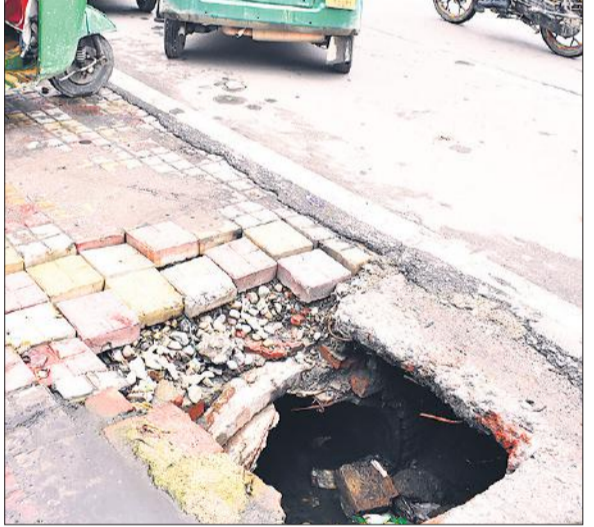
सिविल लाइंस रोड पर टूट गई है टाइल्स, खुली नाली हादसे की आशंका पैदा कर रही है।
