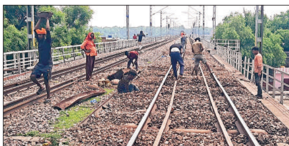
रेलवे पुल पर पटरी बदलने का काम करते रेल कर्मी।
