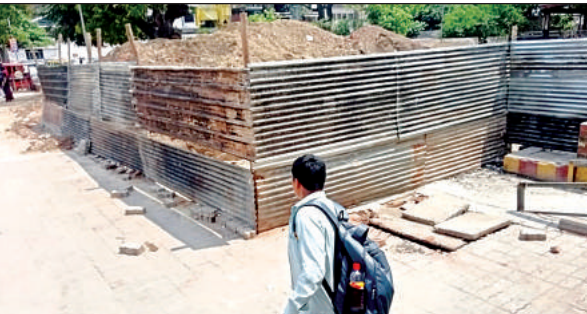
टीन की चादरों से घेरा गया अमृत स्टेशन का निर्माण स्थल।
