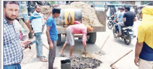
सड़क के गड्डे भरते लोक निर्माण विभाग के श्रमिक।
