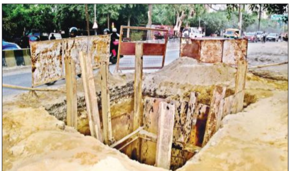
महिला पोलिटेक्निक के पास चल रहा सीवर पाइप लाइन का निर्माण कार्य।
