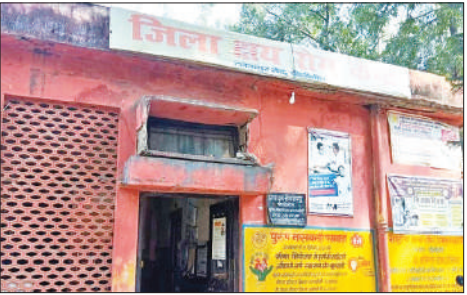
जिला क्षय रोग अस्पताल का भवन।
