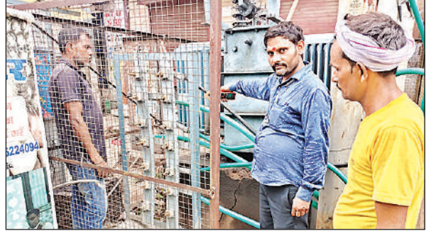
एसडीओ की मौजूदगी में ट्रांसफार्मर में लगाया जाता टेल लेस यूनिट। अमृत विचार
