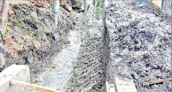
नगर पंचायत बरखेड़ा के निर्माणधीन नाले में इस तरह ढही थी दीवार।
