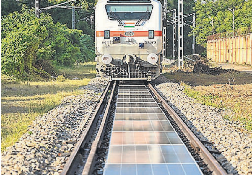
भारतीय रेलवे ने हरित ऊर्जा और तकनीकी नवाचारी दिशा में बड़ा कदम उठाया है। वाराणसी स्थित बनारस लोकोमोटिव वर्क्स ने रेल की ट्रैकरियों के बीच, देश का पहला रिमूवेबल सोलर पैनल सिस्टम लगाया है।
