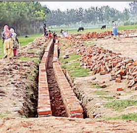
मुख्य मार्ग के किनारे होता नाला निर्माण कार्य।
