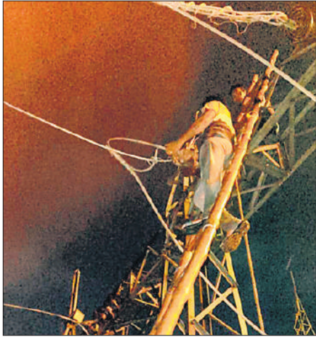
रामलीला लाइन का फाल्ट ठीक करते कर्मचारी।
