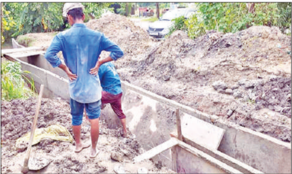
बनकटी रोड पर गिरे निर्माणाधीन नाले का सुधार करती लेबर।
