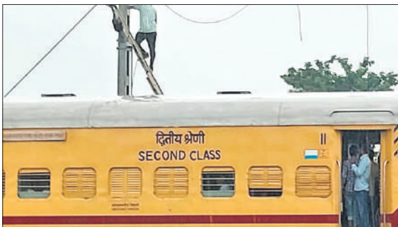
क्षतिग्रस्त ओएचई लाइन को दुरुस्त करते कर्मचारी।
