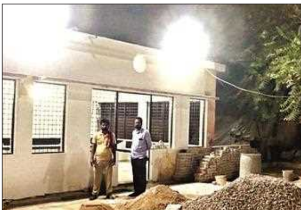
बस स्टैंड परिसर मेंपड़ी निर्माण सामग्री।
