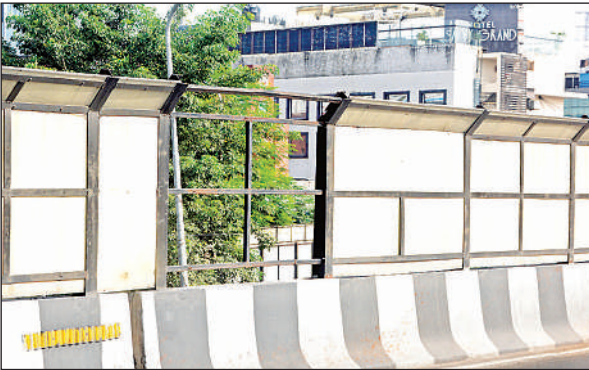
लोहिया अस्पताल से फन माल जाने वाले पुल की टूटी फाइबर की रेलिंग।
