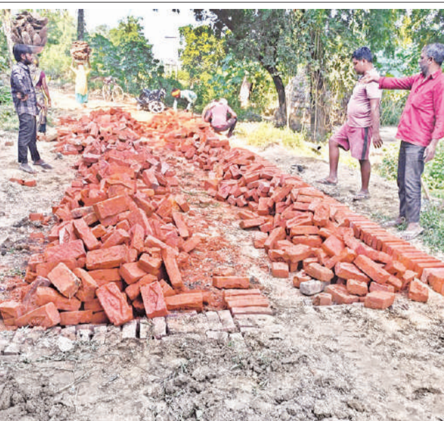
सड़क निर्माण में पीले ईट का हो रहा इस्तेमाल।
