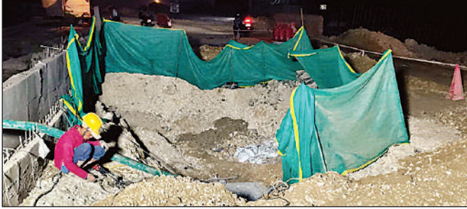
साकेत सदन के पास धंसी सड़क पर चल रहा सीवर लाइन की मरम्मत का काम।
