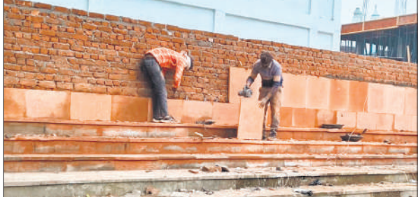
गोला में गोकर्ण तीर्थ की दक्षिण दीवार पर लाल पत्थर लगाते श्रमिक।
