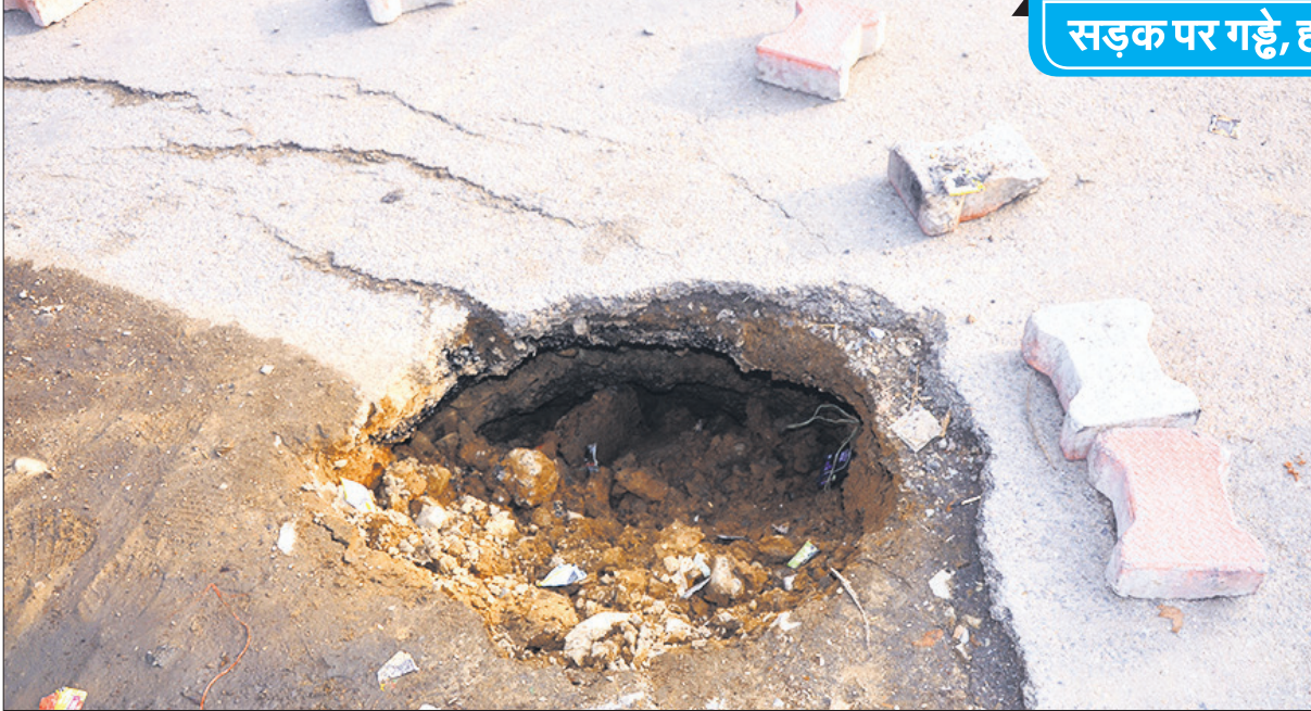
शुक्रवार हुई बरसात में नगर निगम शौचालय के पास सड़क फिर घंस गई। करीब दो महीने पहले इसी जगह सीवर लाइन पड़ी थी। वहीं, पीलीभीत बाईपास रोड पर भी गड्ढे हो गए हैं। इसकी वजह से हादसे का डर बना हुआ है।
