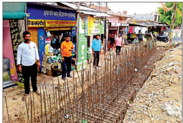
नाला निर्माण के लिए पड़ा सरियों का जाल।
