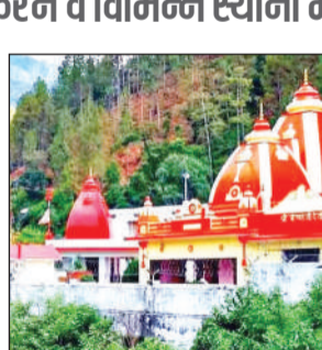
को नैनीबैड-सेनिटोरियम बाईपास और भीमताल बाईपास स्थित निर्माणाधीन नहर कवरिंग को जल्द पूरा करने के निर्देश भी दिए। लोनिवि के अधिशासी अभियंता को कैंची धाम में निर्माणाधीन पाथवे
