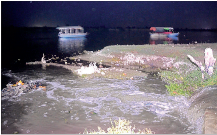
बुधवार रात करीब 8 बजे परमट घाट पर बिजली बंद करके टेप टैपको नाले का बाल्ट खोलकर कर्मचारी (इनसेट) ने हजारां लीटर गंगा पानी गंगा में बहा दिया। अमृत विचार फोटो जर्नलिस्ट ने यह धांधली अपने कैमरे में कैद की।
