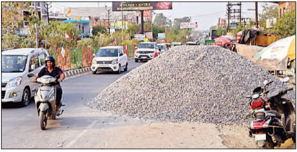
इस तरह आधे फोरलेन तक फैली है निर्माण सामग्री।
