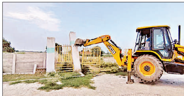
अवैध रूप से बने गेट को ध्वस्त करत बुलडोजर।
