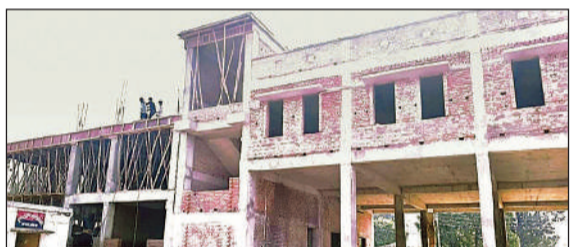
पुलिस लाइंस में निर्माणाधीन अग्निशमन विभाग का प्रशासनिक भवन।
