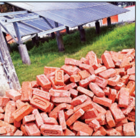
टंकी निर्माण में लगाई जा रही पीली ईट।
