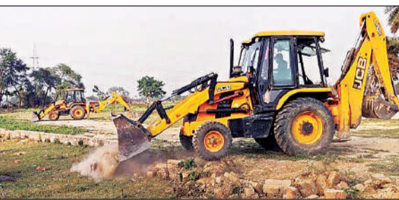
अवैध निर्माण पर चलती जैसीबी।
