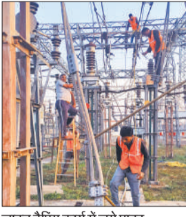
लाइन टैपिंग कार्य में लगे पावर कॉरपोरेशन के कर्मचारी।
