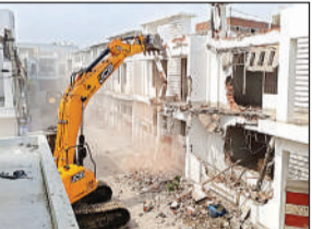
बिजनौर स्थित अवैध मॉड गैलेक्सी सिटी के भवन पर चलता बुजडोजर।
