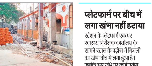
स्टेशन के मुख्य द्वार पर हो रहा निर्माण कार्य।
