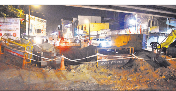
शहामतगंज चौराहे पर पुल के नीचे सीवर लाइन जोड़ने को की गई खोदाई।
