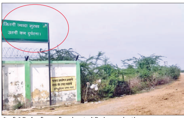
सैजनी में निर्माणाधीन एचपीसीएल के प्लांट में लिखे सुरक्षा के संदेश।
