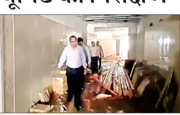
निर्माणाधीन क्रिटिकल यूनिट सेंटर का निरीक्षण करते मुख्य चिकित्साधिकारी।
