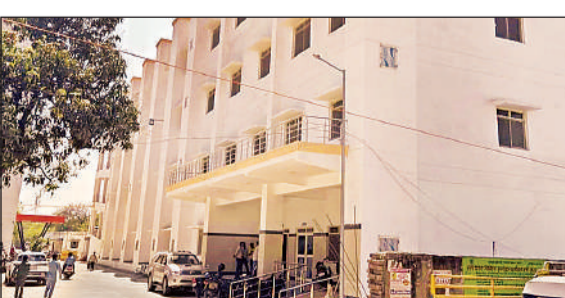
मेडिकल कॉलेज में ट्रॉमा सेंटर का नवनिर्मित भवन। अमृत विचार
