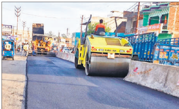
राजापुर से नहर पुलिया तक बनाई जा रही हॉटमिक्स सड़क।
