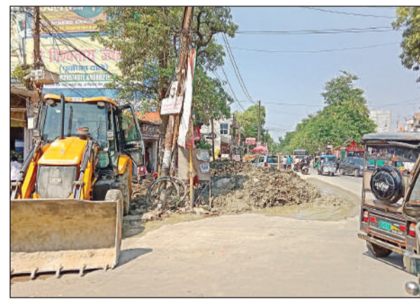
गुलाबी बिल्डिंग के पास लीकेज की मरम्मत की गई।
