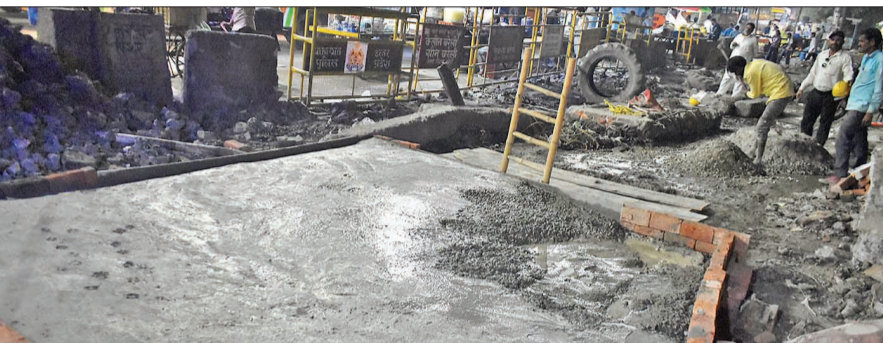
सेटलाइट पर नाले के ऊपर स्लैब डालने का चल रहा काम।
