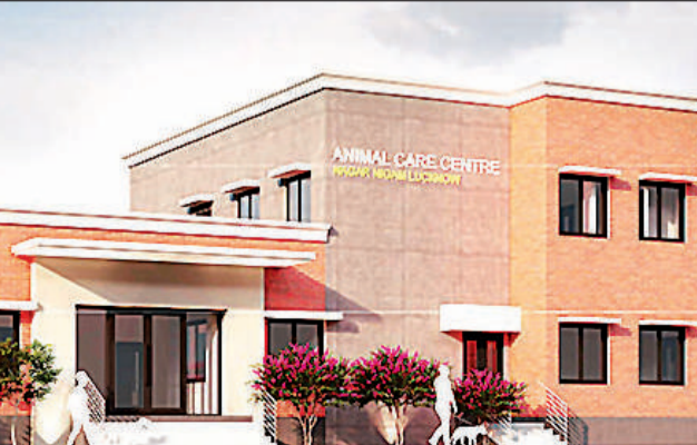
भरवारा में निर्मित एनिमल केयर सेंटर का भवन।
