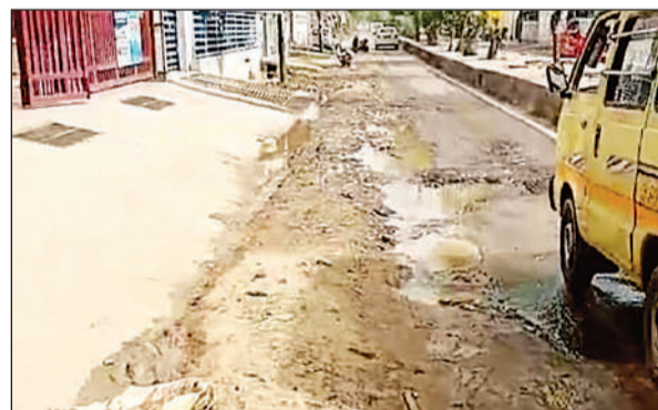
केबल डालने के लिए खोदी गई सड़क।
